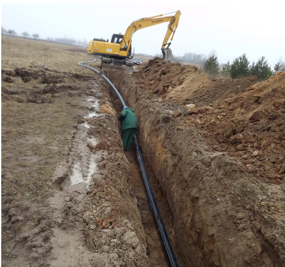
Spaudiminės kanalizacijos įrengimo darbai, Anykščių rajone
